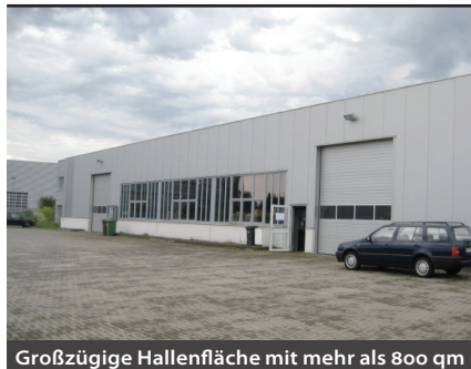
Großzügige Hallenfläche mit mehr als 800 qm
